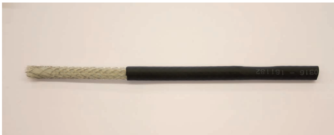
1. Außenmantel mit einem Messer ca. 80 mm abisolieren.
