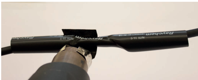
9. Aussenschumpfschlauch mittig über Konfektionierung schieben und von der Mitte aus aufföhnen.
