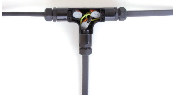
7. Schutzgeflecht (bzw. Erdung) mittels Klemme verbinden - Litze 1 mittels Klemme verbinden - Litze 2 mittels Klemme verbinden
