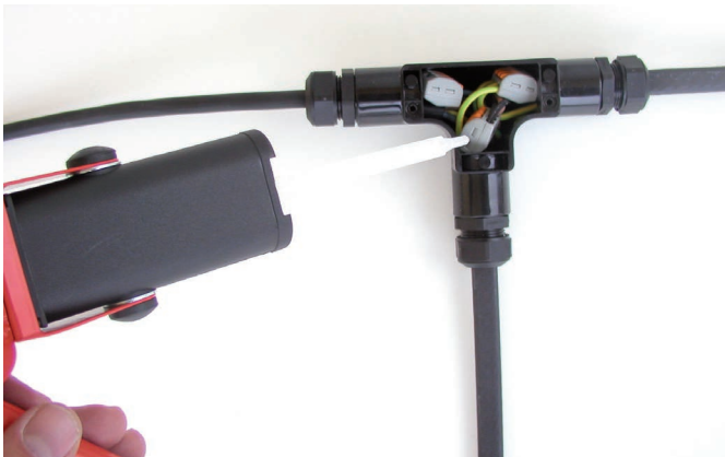
8. Innenraum des T-Abzweiges mittels Gießharz ausfüllen, Deckel montieren und ca. 1 Stunde trocknen lassen. Zugkräfte dürfen erst nach 24 Stunden auf die T-Abzweigung wirken, da erst dann das Gießharz vollständig ausgehärtet ist.
