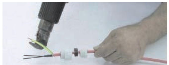
6. Föhnen Sie den Erdungsschrumpfschlauch mittels Heißluftföhn auf.
