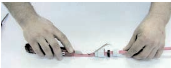
3. Schneiden Sie die Innenisolierung mittels Messer ca. 70 mm ab und entfernen sie.
