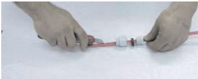
1. Isolieren Sie den Außenmantel mit einem Messer ca. 80 mm ab. Schieben Sie die 3-teilige M-20-Verschraubung auf.
