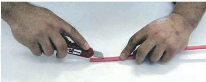
1. Isolieren Sie den Außenmantel mit einem Messer ca. 80 mm ab.
