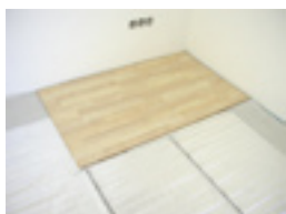
Laminat schwimmend verlegen
