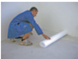
Dämmung verlegen
